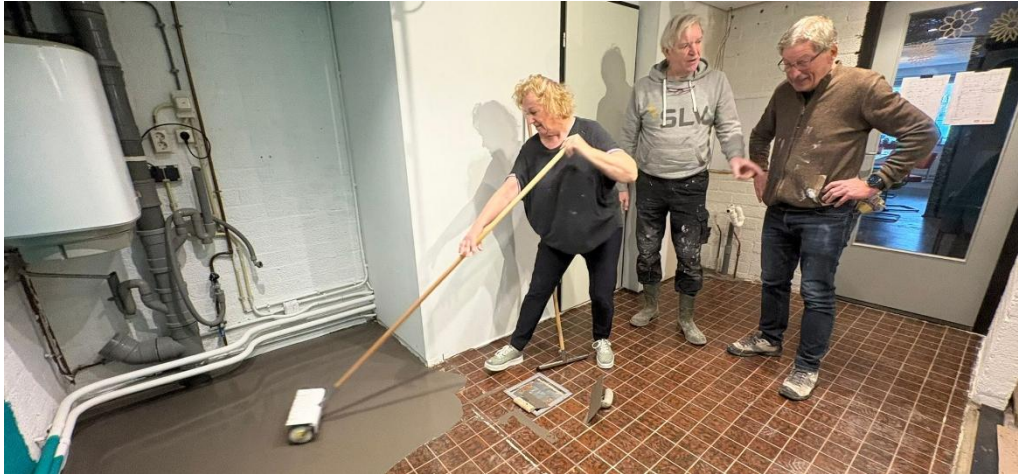
Annie Heesters, midden op de foto, neemt zelf het voortouw bij het leggen van de primer op de vloer voor de nieuwe keuken in de Buurtkamer.
