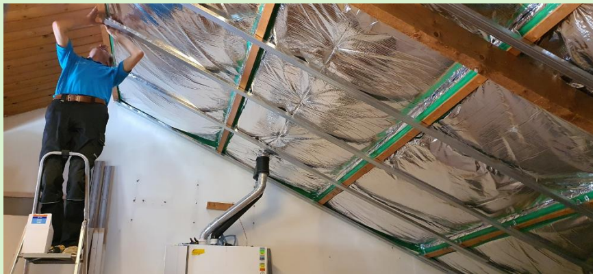
Dakisolatie kan leiden tot 30% energiebesparing.
