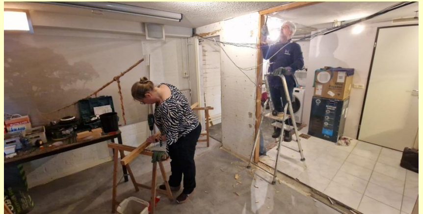
Er is deze winter door verschillende buurtbewoners hard gewerkt aan de verbouwing, het uitbreken en uitbreiden van de Buurtkamer.
