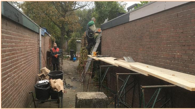
Eind oktober is Ekogras begonnen met de aanleg van groendaken bovenop 26 schuren in de Buitenpepers.
